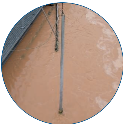
Fig. 2: Sensor de oxigénio LDO em utilização
